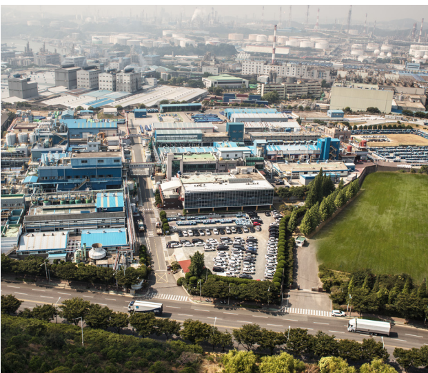
1979년에 설립된 바스프컬러스앤이펙츠코리아(주) 울산 안료공장 전경
